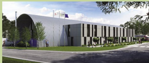
ZAKŁAD LIFECOGENERATION.PL W CENTRUM BADAWCZO-ROZWOJOWYM INWESTEKO W ŚWIĘTOCHŁOWICACH
